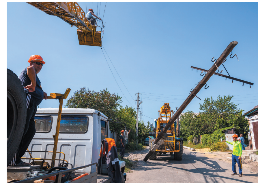
Ремонт електромереж у Мереф'янській громаді
