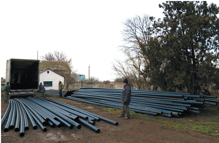
Реконструкція водогону в селі Григорівка в межах Програми USAID DOBRE
