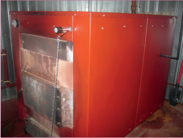
Котел опалювальний піролізний КОП-ВД
