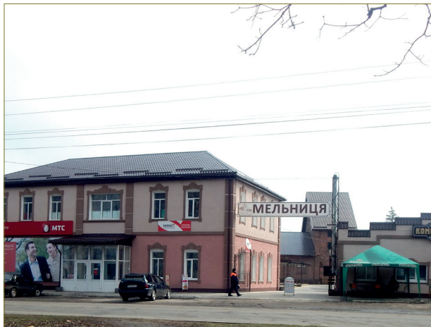
Торговий центр «Мельниця», споруджений на місці збанкрутілого ВАТ «Тростянецький КХП»
