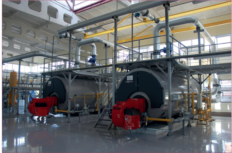
Реконструйована газова котельня по вул. Баженова, 15
