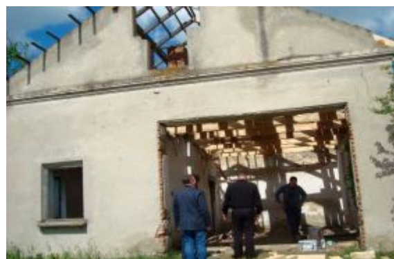
Проведення ремонту будівлі пожежного депо
