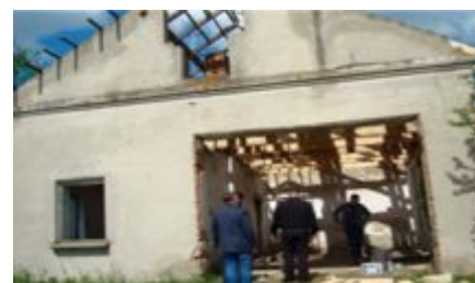
Стан будівлі до ремонту
